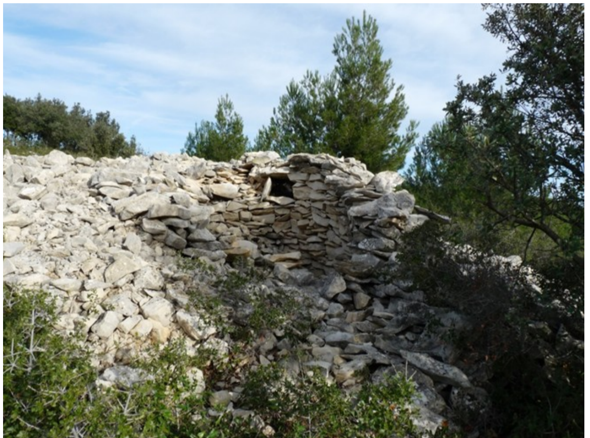
Avant la restauration
